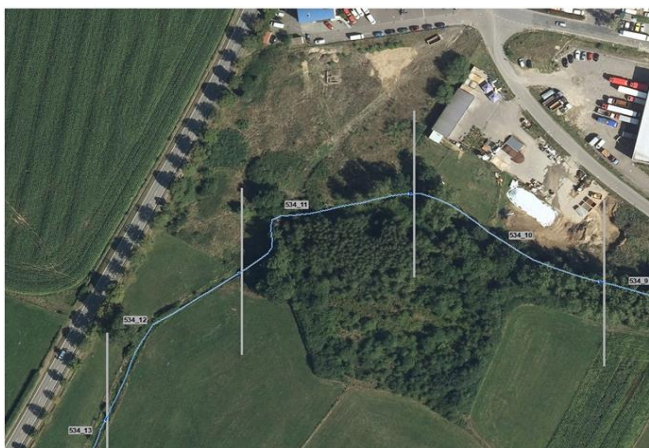
Foto gegen Fließrichtung
