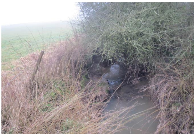
Foto gegen Fließrichtung
