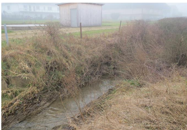
Foto gegen Fließrichtung
