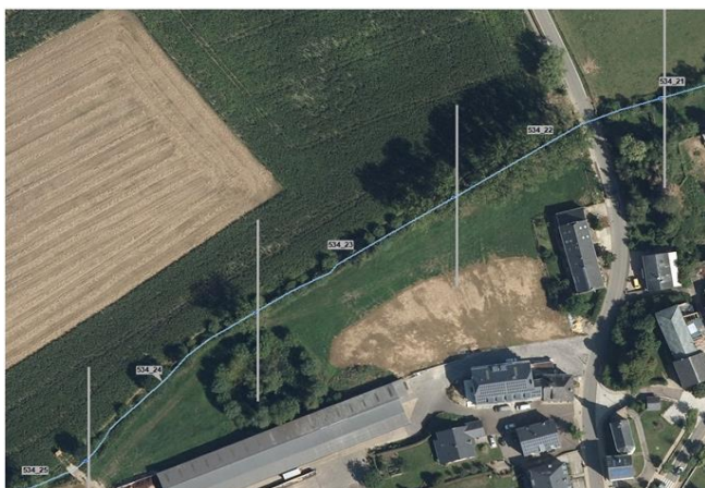
Foto gegen Fließrichtung
