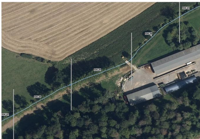
Foto gegen Fließrichtung
