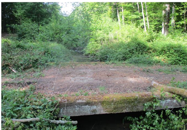
Foto gegen Fließrichtung
