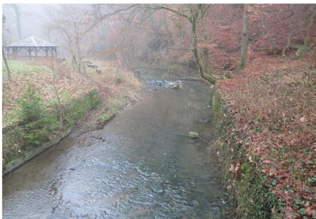
Foto gegen Fließrichtung
