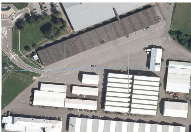
Foto gegen Fließrichtung
