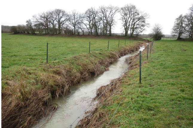
Foto gegen Fließrichtung
