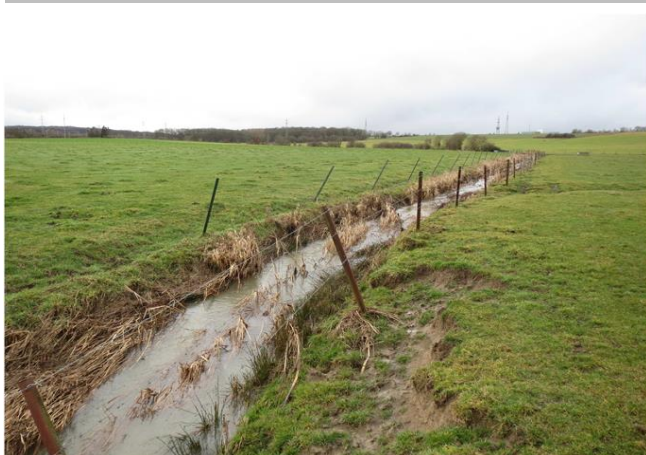
Foto gegen Fließrichtung
