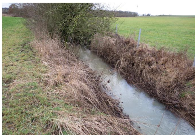
Foto gegen Fließrichtung
