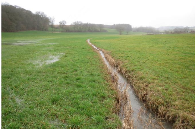
Foto gegen Fließrichtung
