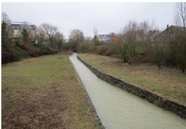
Foto gegen Fließrichtung
