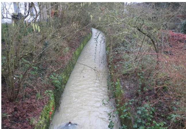
Foto gegen Fließrichtung
