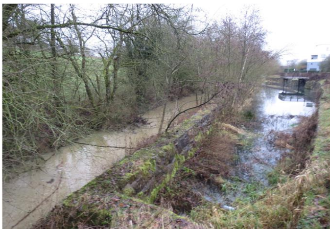
Foto gegen Fließrichtung
