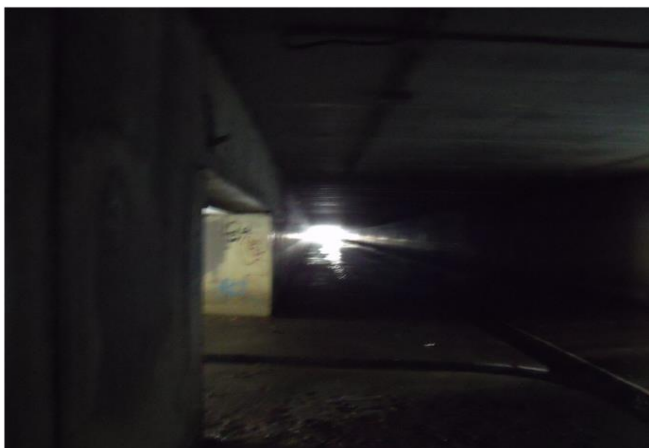
Foto gegen Fließrichtung
