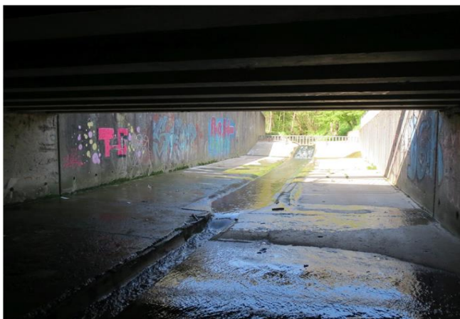
Foto gegen Fließrichtung
