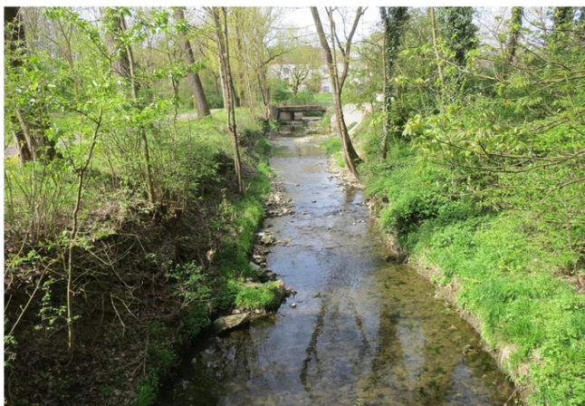
Foto gegen Fließrichtung
