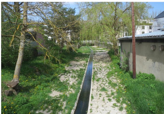
Foto gegen Fließrichtung
