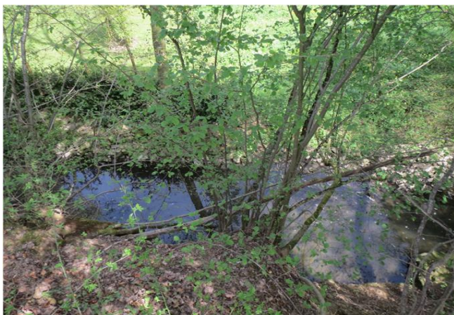
Foto gegen Fließrichtung
