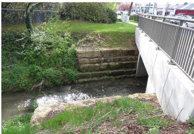
Foto gegen Fließrichtung
