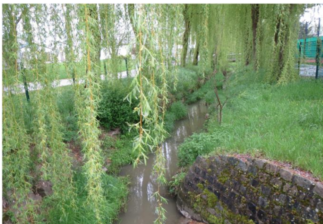
Foto gegen Fließrichtung
