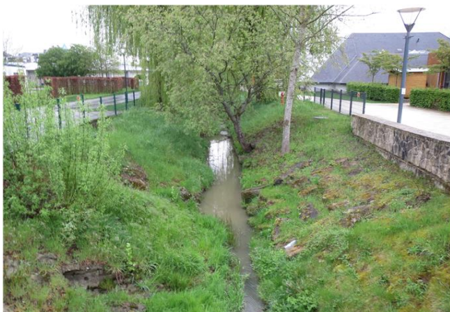
Foto gegen Fließrichtung
