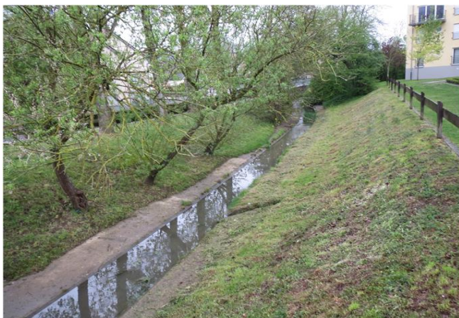
Foto gegen Fließrichtung
