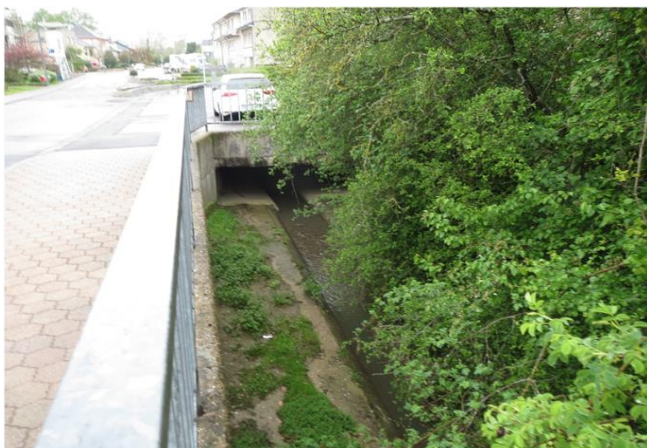
Foto gegen Fließrichtung
