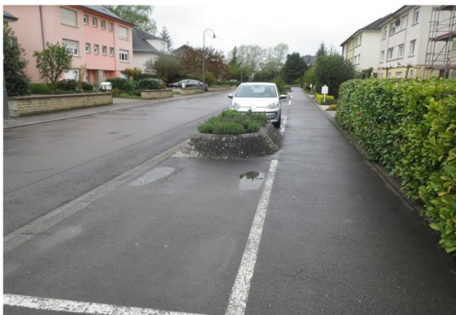
Foto gegen Fließrichtung
