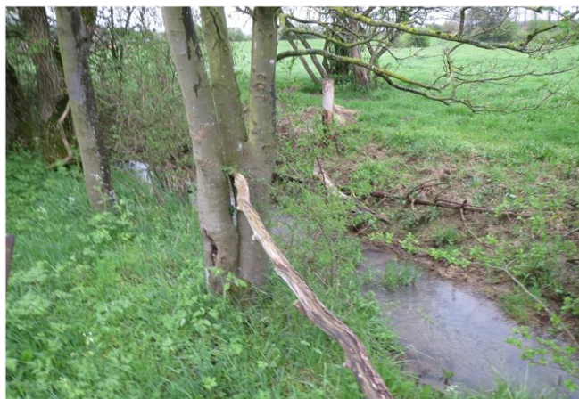
Foto gegen Fließrichtung
