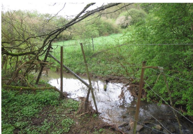
Foto gegen Fließrichtung
