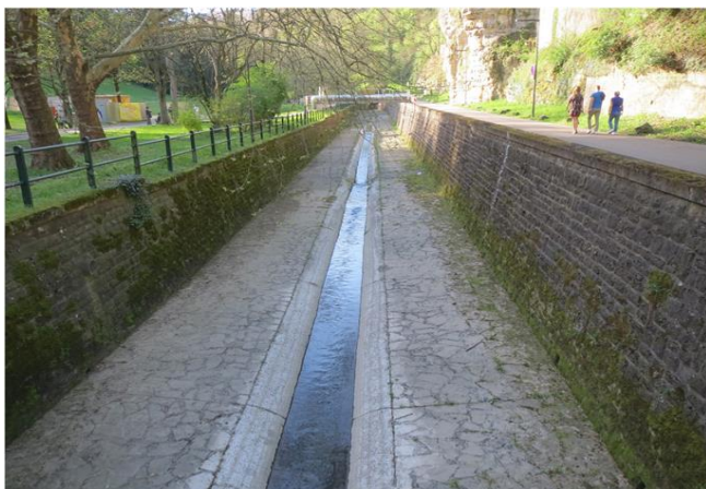
Foto gegen Fließrichtung
