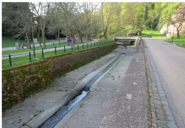
Foto gegen Fließrichtung
