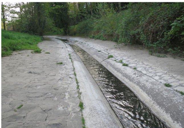
Foto gegen Fließrichtung
