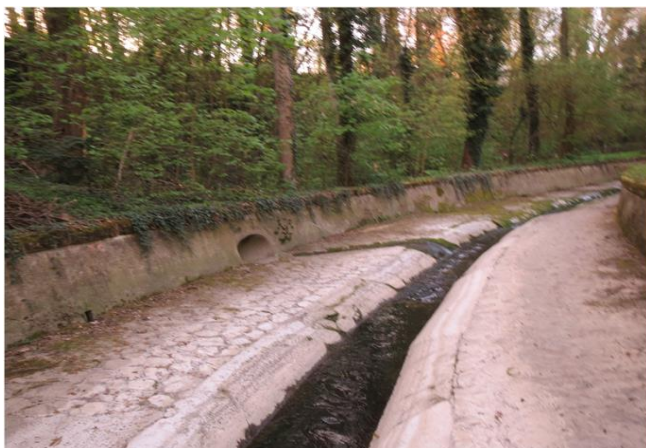
Foto gegen Fließrichtung
