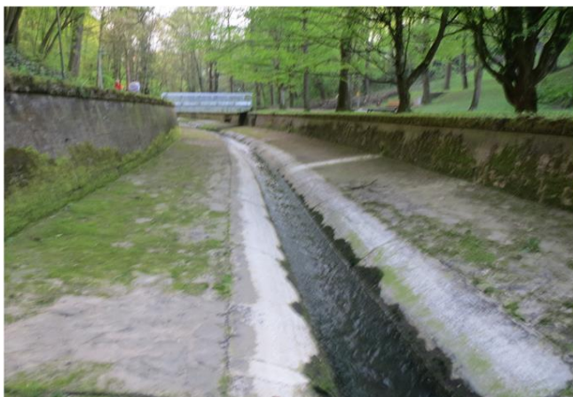
Foto gegen Fließrichtung
