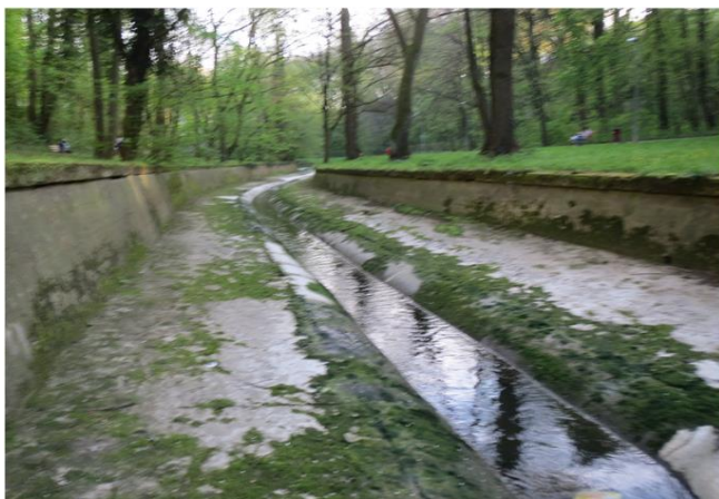
Foto gegen Fließrichtung
