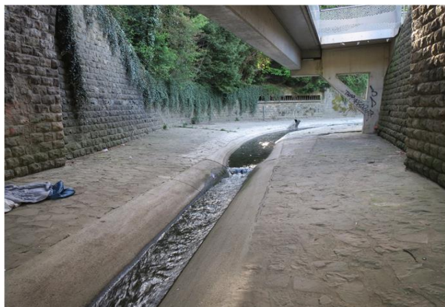
Foto gegen Fließrichtung
