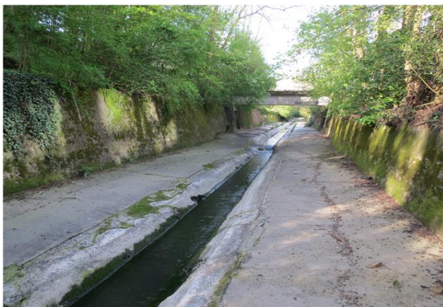
Foto gegen Fließrichtung
