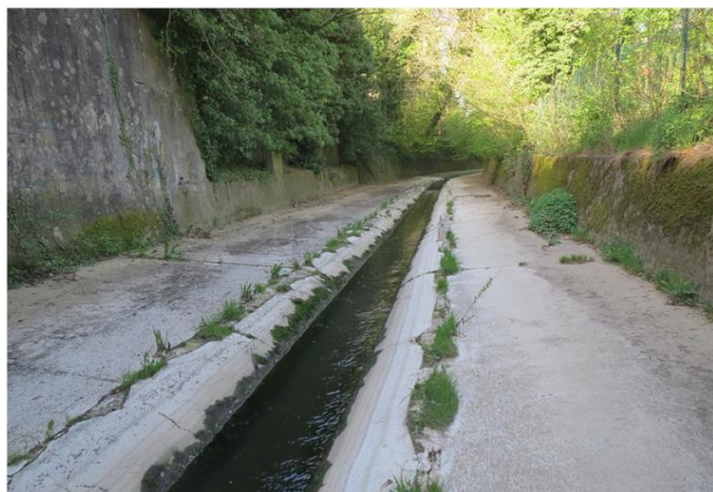
Foto gegen Fließrichtung
