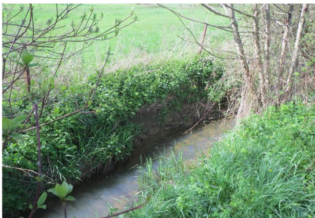
Foto gegen Fließrichtung
