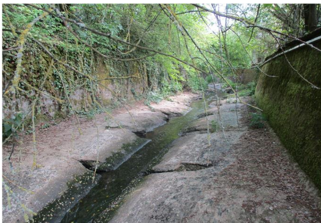
Foto gegen Fließrichtung
