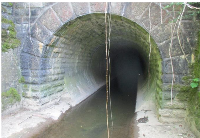
Foto gegen Fließrichtung
