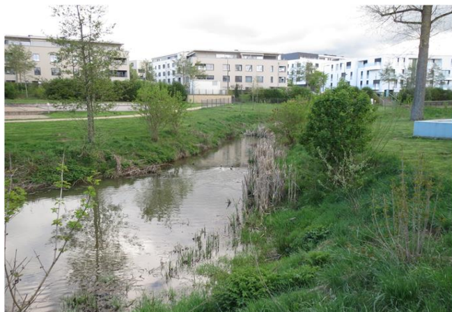
Foto gegen Fließrichtung
