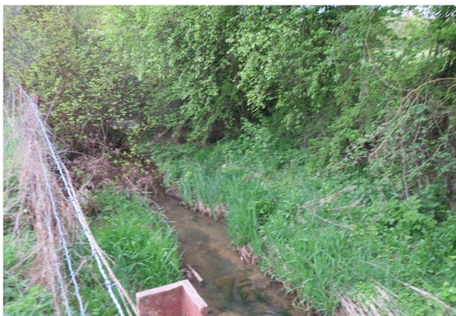
Foto gegen Fließrichtung
