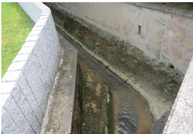
Foto gegen Fließrichtung
