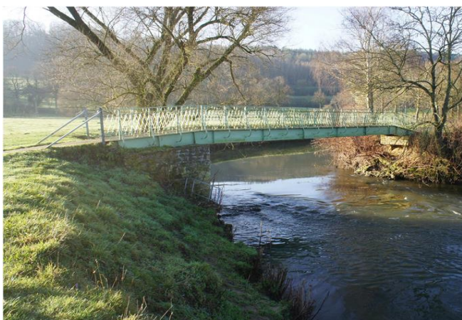
Foto gegen Fließrichtung
