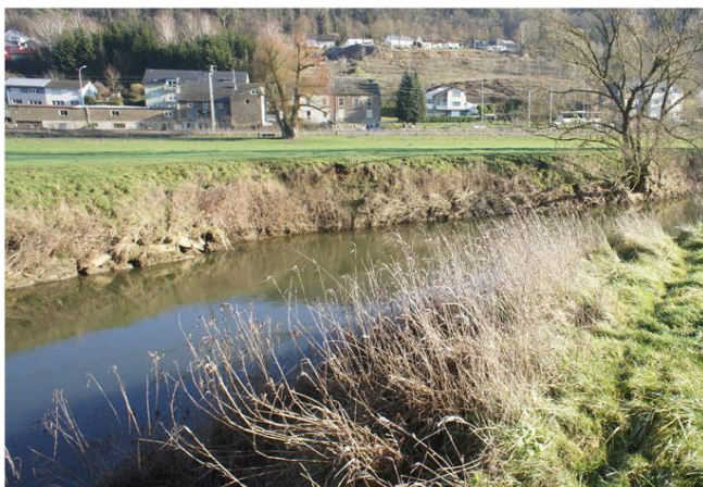
Foto gegen Fließrichtung
