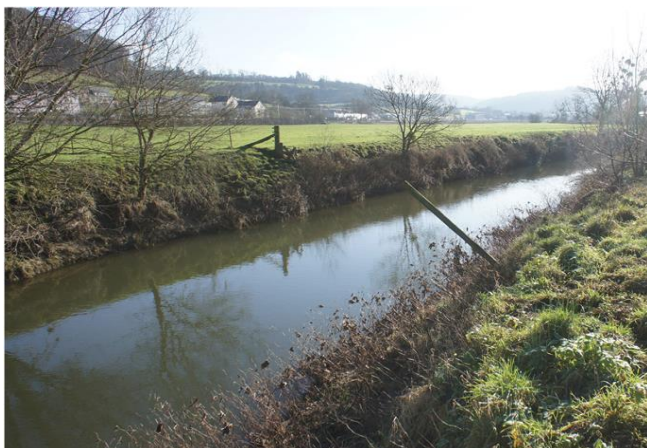
Foto gegen Fließrichtung
