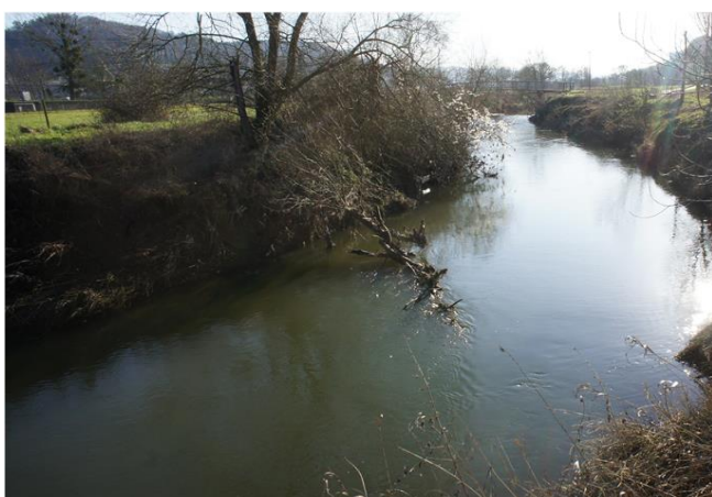
Foto gegen Fließrichtung
