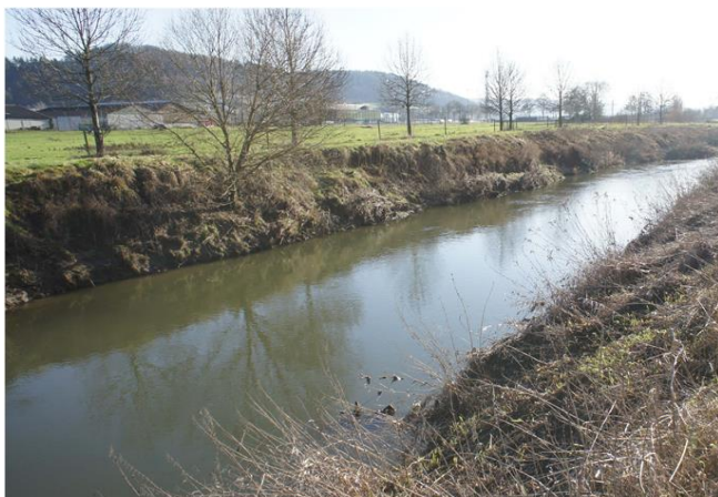
Foto gegen Fließrichtung
