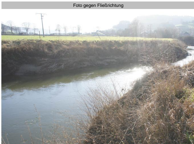
Foto gegen Fließrichtung
