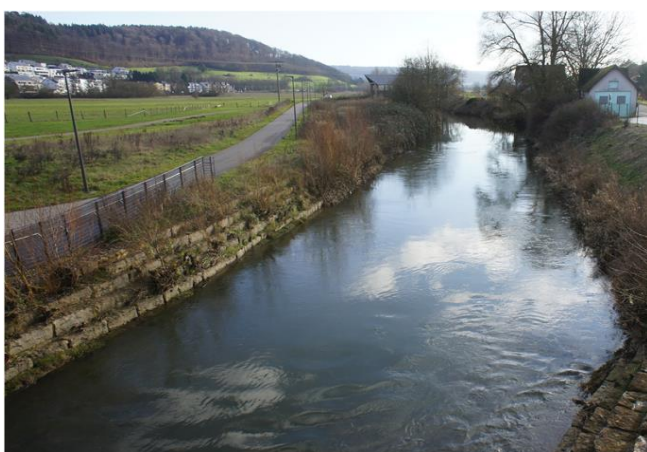
Foto gegen Fließrichtung
